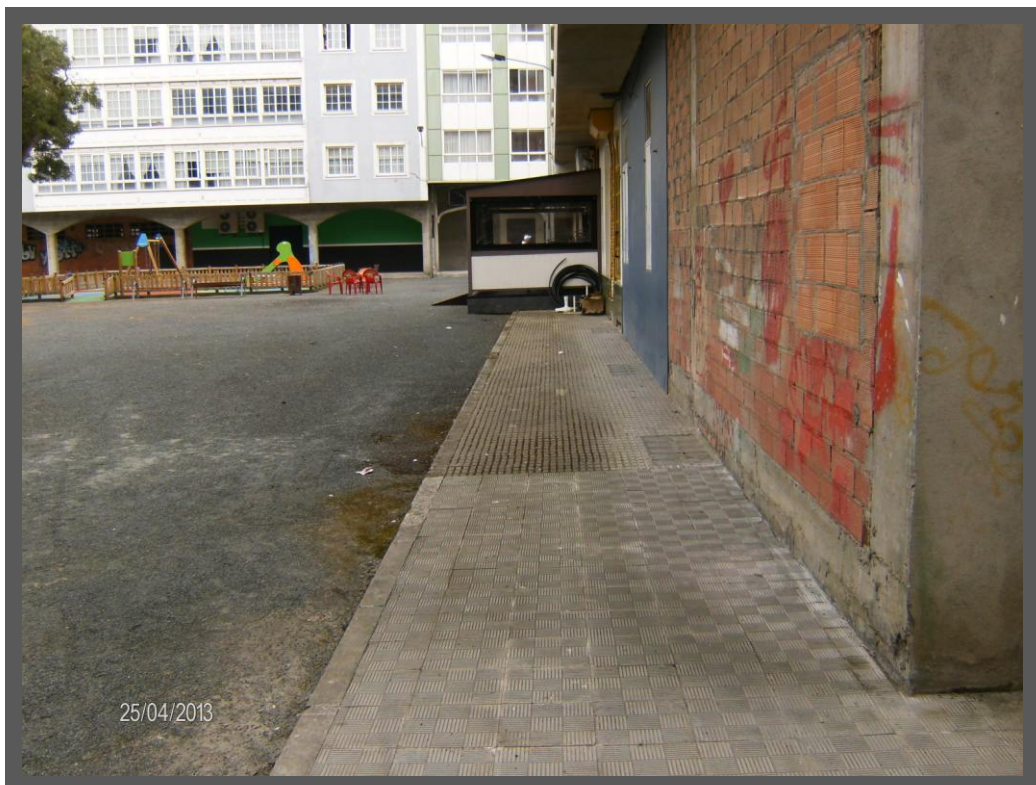
Foto n° 14: Vista de acera a demoler.
