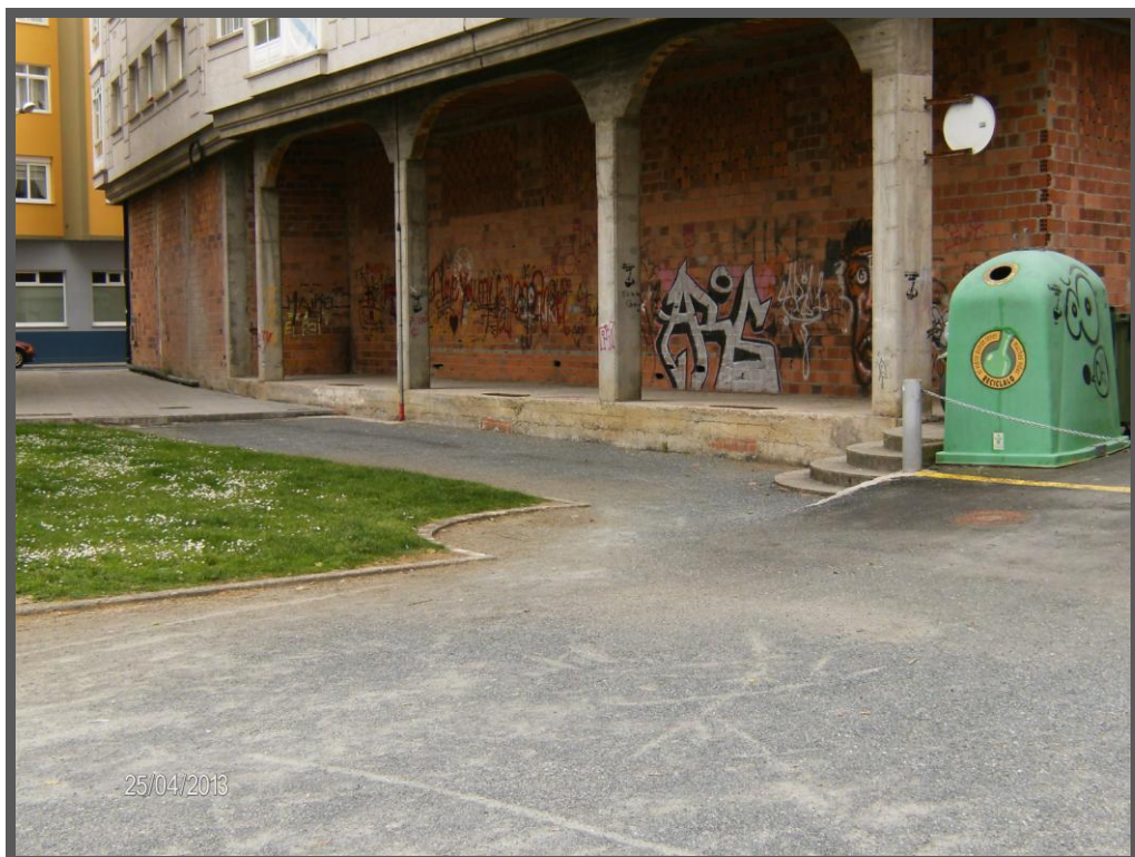
Foto nº 10: Vista de parterres y soportales.
