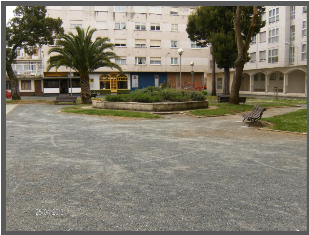
Foto nº 11: Vista general de la Plaza a reformar.
