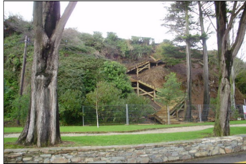
Escaleiras de Crónicas en obras
